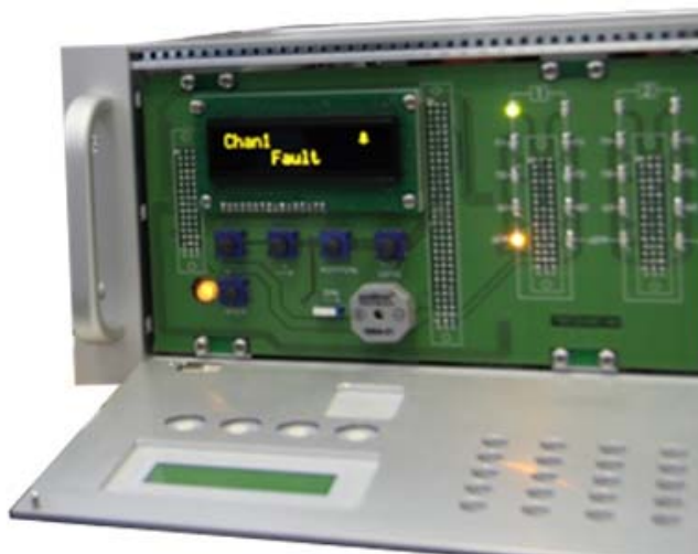
Рис. 3.2 Неисправность ИПЭС (запыленность), отображение индикации неисправности на УПЭС. Сопровождается звуковой сигнализацией
